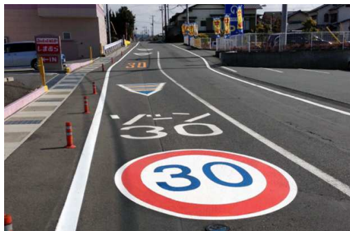
※貼りつけシートによるゾーン30
