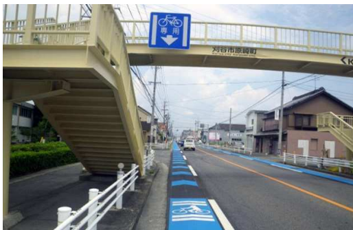
※自転車専用通行帯の標識
