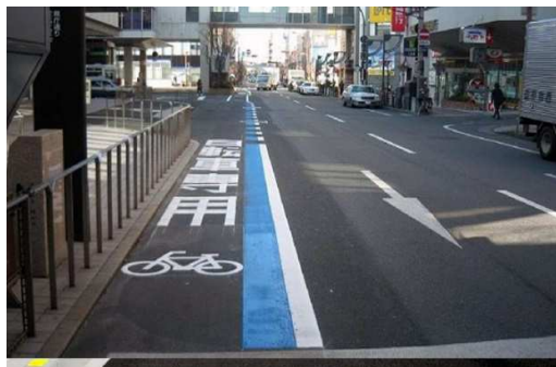
※柵で区画した自転車専用通行帯
