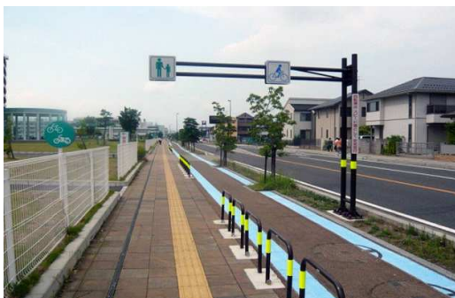
※自転車・歩行者分離のガードパイプ
