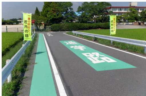
※路肩と車道に緑色のカラー標示
