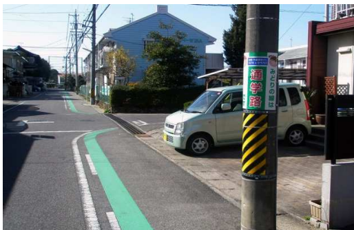
※電柱への通学路標識
