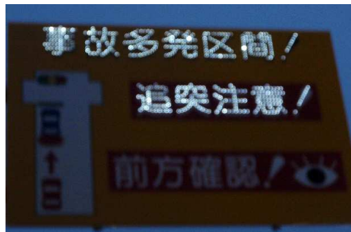
※事故多発区間自発光式大型警戒標識
