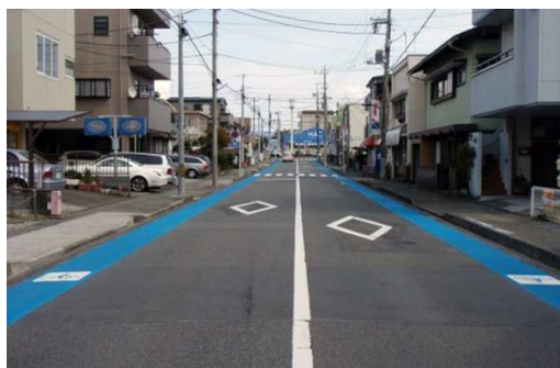
⑥ 静岡県沼津市地内
