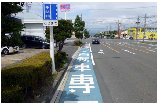
※自転車専用通行帯の標識
